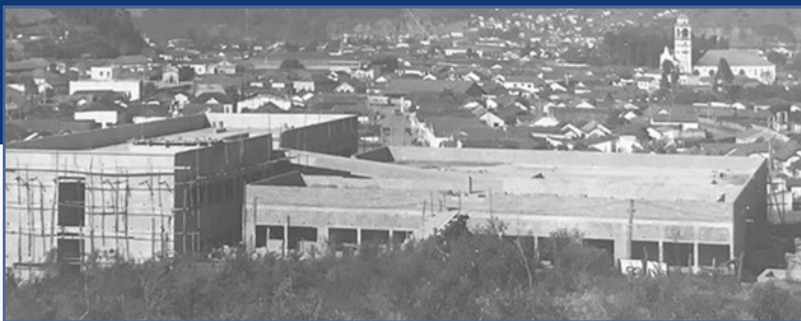
Obras do Hospital de Clínicas de Itajubá
